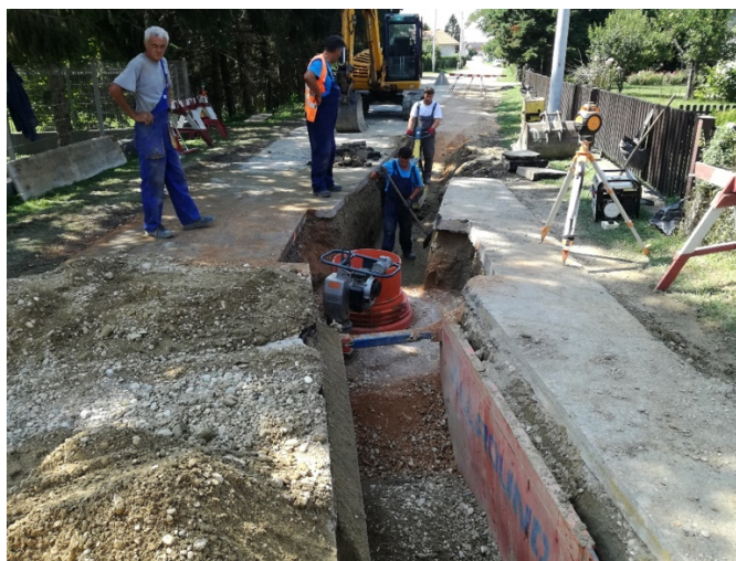
Zbijanje rova nakon ugradnje cjevovoda na cjelini A.3.4
