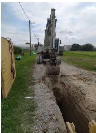
Izgradnja gravitacijskog kolektora na cjelini A.1.8.
