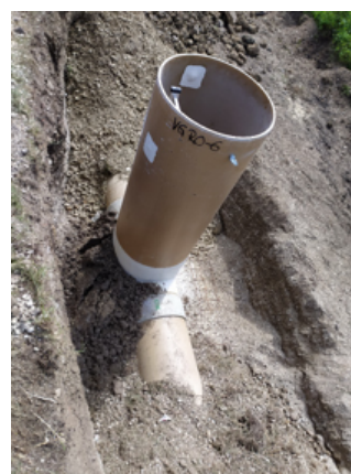
Postavljanje okna na cjelini A.1.7.
