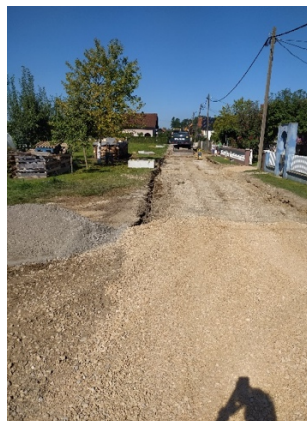
Ugradnja tampona i priprema za asfaltiranje na cjelini A.2.3
