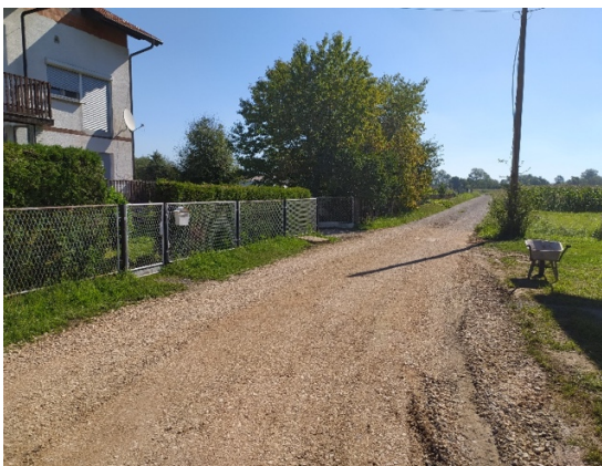
Ugradnja tampona i priprema za asfaltiranje na cjelini A.2.3
