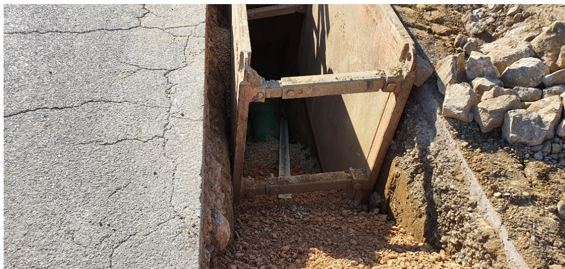
Zatrpavanje rova zamjenskim materijalom
