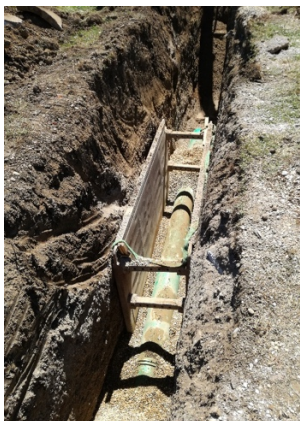
Zatrpavanje cijevi pijeskom
