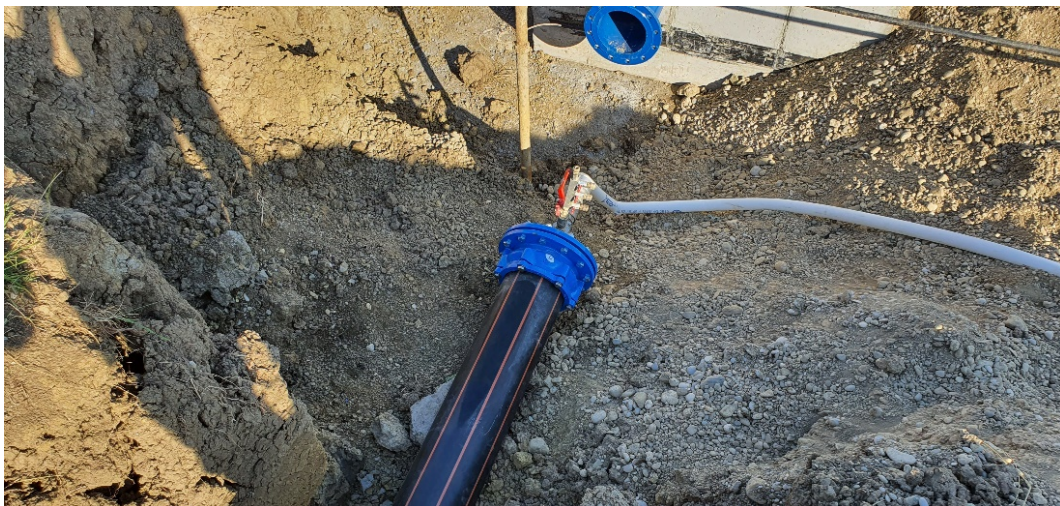
Uvećani prikaz - tlačna proba cjeline A.2. u naselju Kobilic
