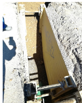
Zatrpavanje rova zamjenskim materijalom
