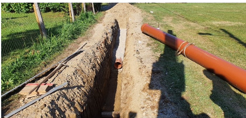
Gravitacijski kanal u naselju Kobilić
