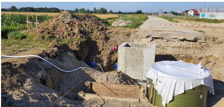
Tlačna proba cjeline A.2. u naselju Kobilić
