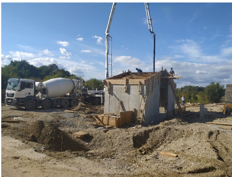
Betoniranje CS Bapča na cjelini A.2.7 Bapča
