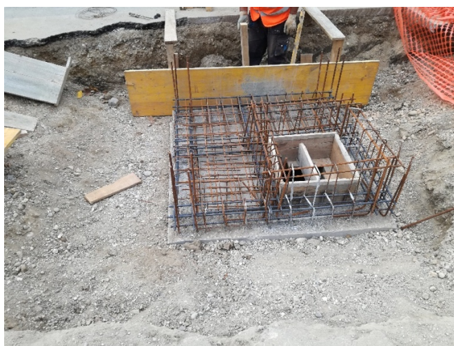
Izrada AB okna na cjelini A.1.8
