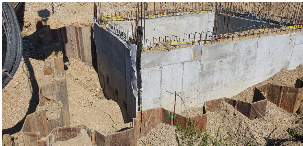
Betoniranje CS Bapča na cjelini A.2.7 Bapča
