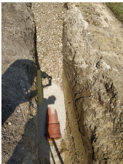
Izgradnja gravitacijskog kanala na cjelini A.2.7 Bapča
