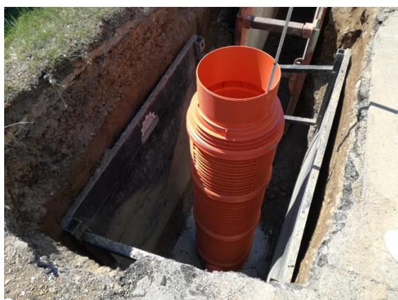
Ugradnja cijevi i okna na cjelini A.3.4
