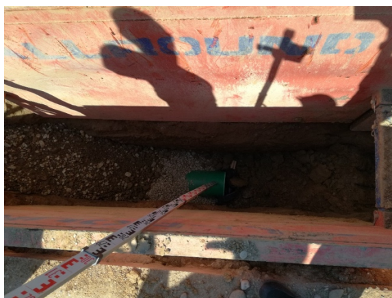
Ugradnja cijevi i okna na cjelini A.3.4
