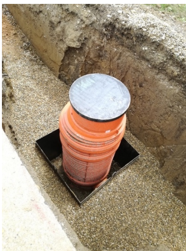
Iskop rova uz korištenje razupore te oplata protu uzgonskog prstena revizijskog okna na cjelini A.1.9. Lukavec
