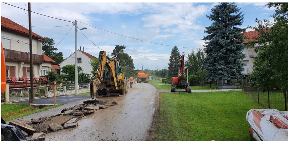
Strojno rezanje, razbijanje i raskopavanje postojećeg asfaltnog zastora kolnika
