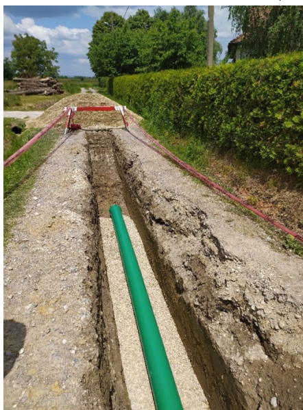
Polaganje cijevi i zatrpavanje rova na gravitacijskom kanalu
