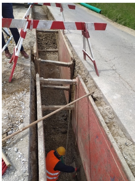
Polaganje cijevi i zatrpavanje rova na gravitacijskom kanalu
