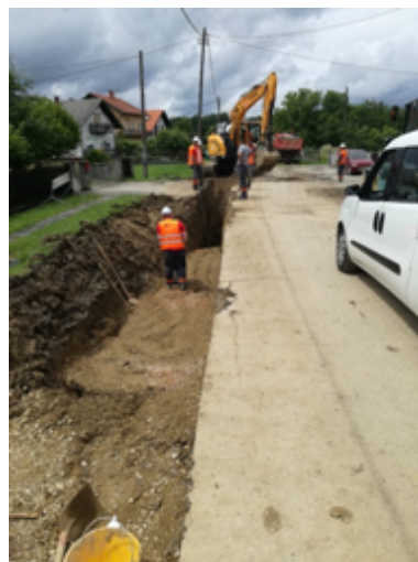
Zatrpavanje rova u slojevima na cjelini A.1.9. Lukavec
