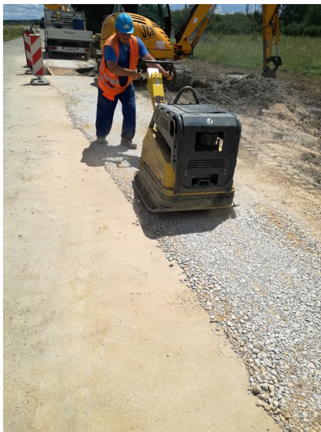
Zatrpavanje uz nabijanje lakim strojnim nabijačima
