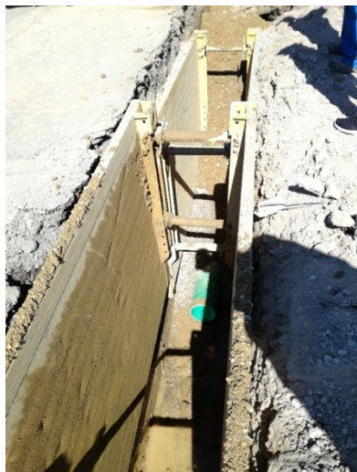
Iskop rova uz korištenje razupore te oplata protu uzgonskog prstena revizijskog okna na cjelini A.1.9. Lukavec
