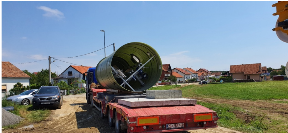
Doprema okna crpne stanice CS Kobilić 2 na gradilište
