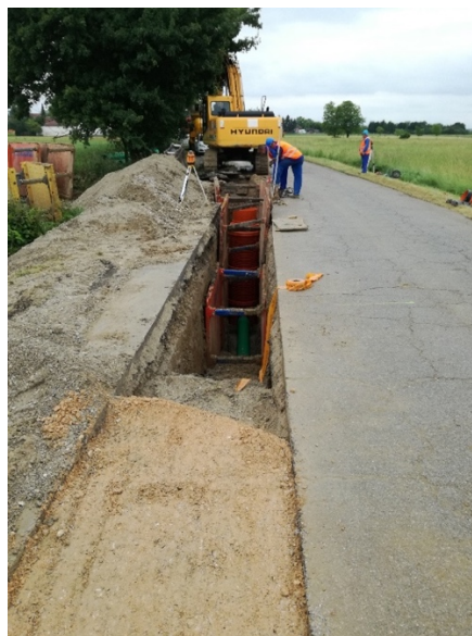
Polaganje cijevi i zatrpavanje rova na gravitacijskom kanalu
