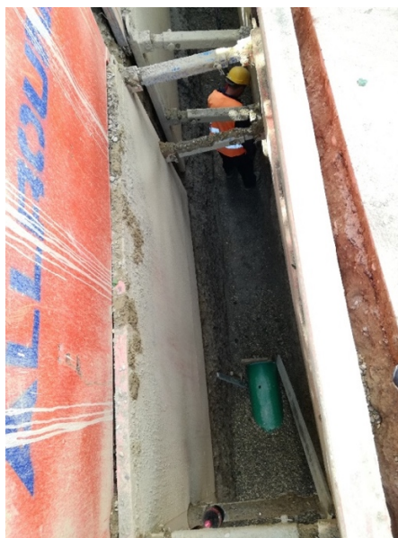
Polaganje cijevi i zatrpavanje rova na gravitacijskom kanalu
