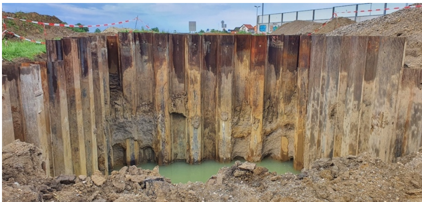
Zabijanje talpi na mjestu ugradnje crpne stanice
